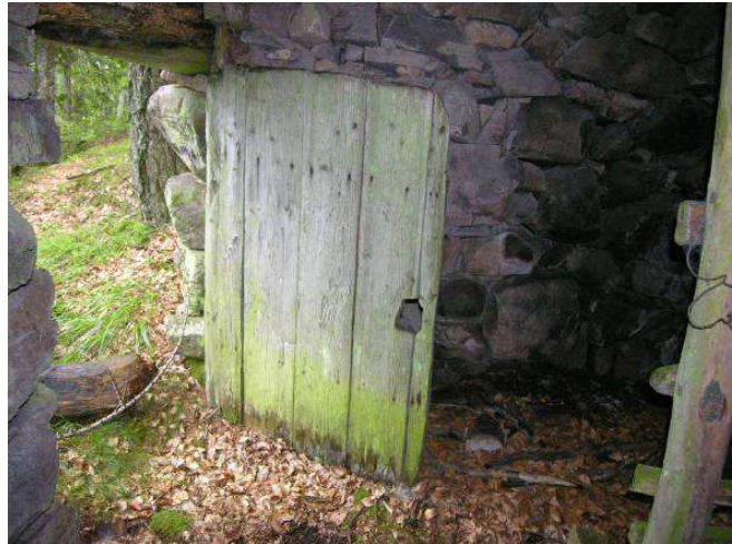
Esempi di porte superstiti realizzate con semplice tavolato verticale verso l'esterno. Travi di rinforzo orizzontali all'interno.
