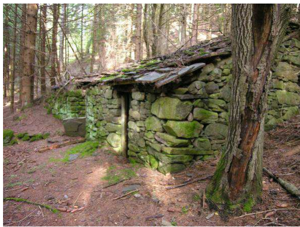
Esempio di ampliamento nella tipologia 2 eseguito in origine. Il nuovo corpo è aggiunto lateralmente.
