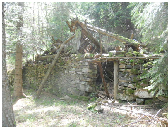
Edificio in cui è riconoscibile il sedime e dove è chiara l'imposta del tetto.
