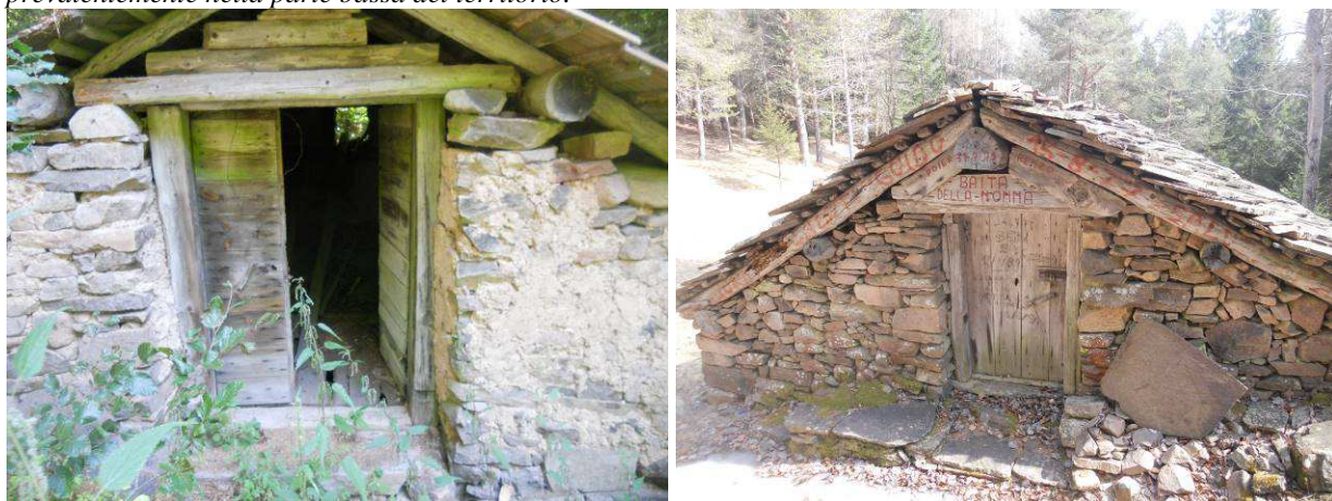
Telaio della porta in legno del prospetto a monte con accesso nel fienile e inserito nella capriata.
