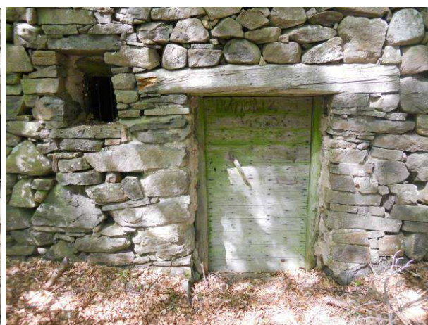
Telaio della porta in legno. L'architrave è realizzata con una grossa trave.
