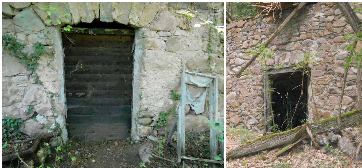
Telaio della porta in legno. L'architrave è realizzata con arco di scarico in pietra. Tipologia presente prevalentemente nella parte bassa del territorio.
