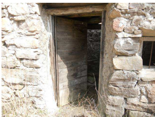
Telaio della porta in legno. L'architrave è realizzata con una grossa trave.
