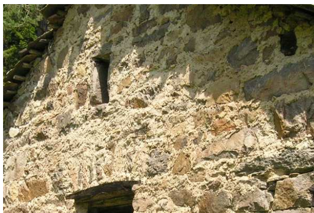
Ricostruzione della muratura con la tecnica del raso sasso
