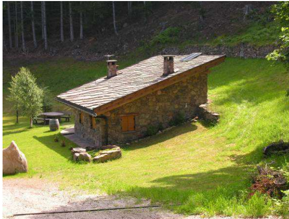
Coperture ricostruite seguendo la tipologia tradizionale. Appaiono eccessivi gli sporti di gronda nella proporzione dell'edificio. I comignoli sono ricostruiti con rivestimento in pietra.
