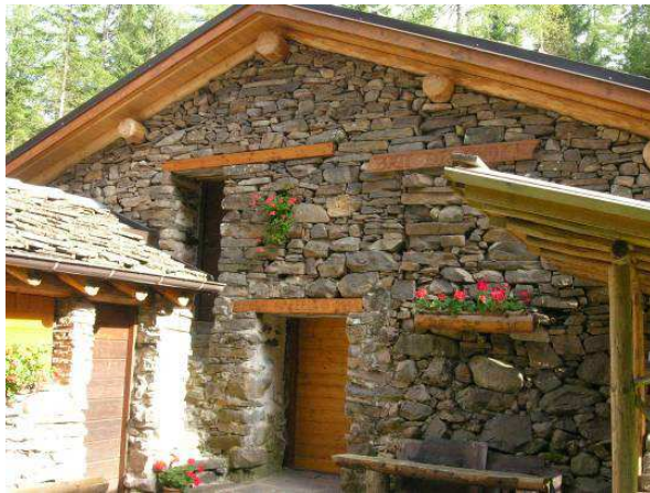
Ricostruzione della muratura con la tecnica del finto secco
