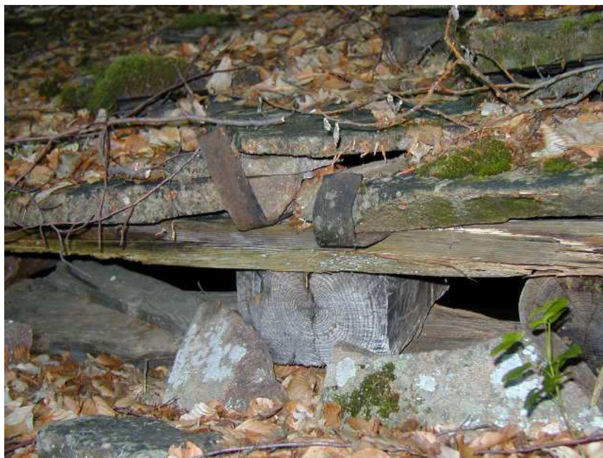
Appoggio della travatura portante alla muratura
