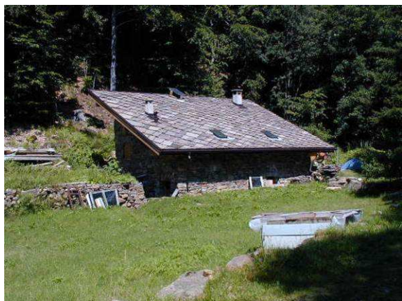
Coperture ricostruite seguendo la tipologia tradizionale. Appaiono eccessivi gli sporti di gronda nella proporzione dell'edificio. I comignoli sono ricostruiti con rivestimento in pietra.
